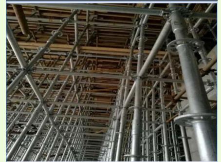
高大支模架工程
