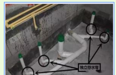
给排水管道安装
