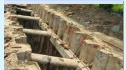
钢板桩施工示意图
