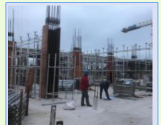
模板工程施工
