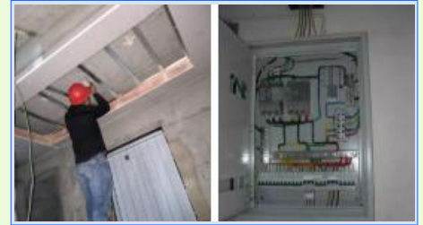
桥架、配管配线安装
