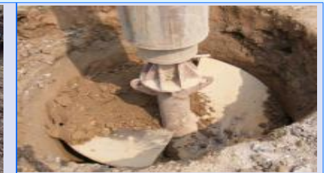
钻机就位旋挖
