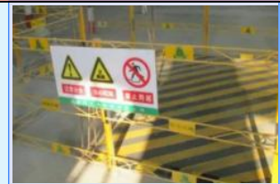
四口五临边安全措施
